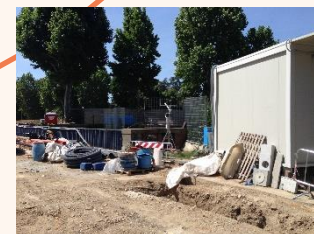
Cantiere della tramvia Firenze
