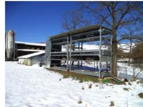
Figura 25: Impianto di essiccazione delle balle di fieno adiacente al locale caldaia seminterrato (in secondo piano)
