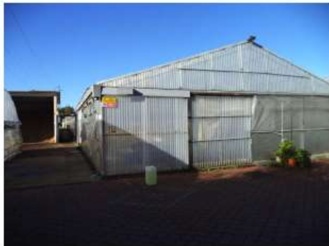
Figura 20: Locale serra per attività florovivaistica. In secondo piano uno dei depositi di stoccaggio del cippato
