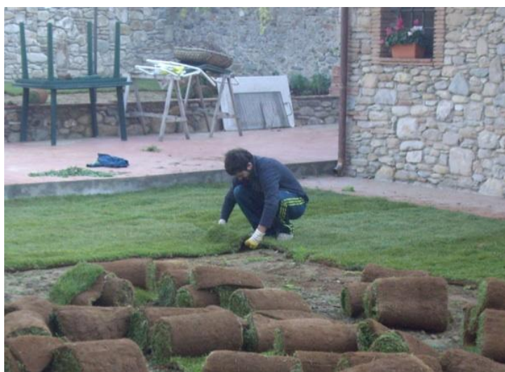
Fig. 4: Impiego di tappeto erboso in rotoli.
