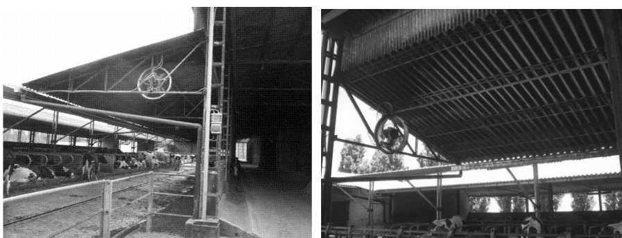
Fig. 6 - Particolari della stalla oggetto della ricerca: in evidenza il sistema di turboventilazione con ugelli per la nebulizzazione dell'acqua.
