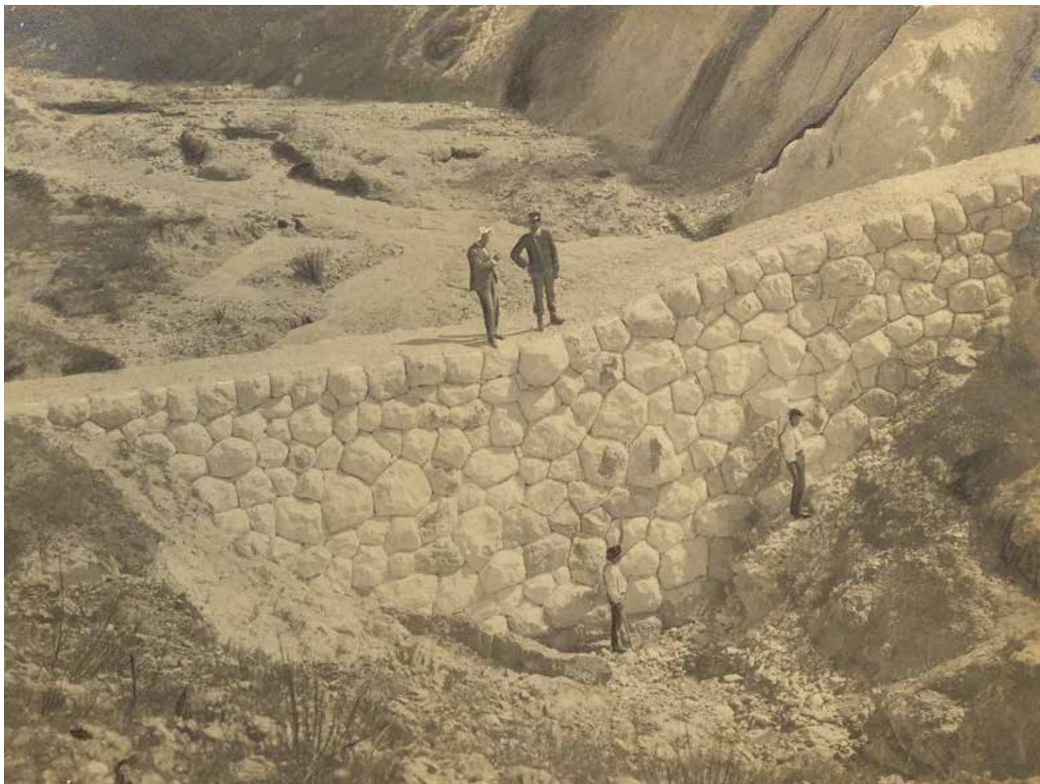
(Fig.56) Briglia di prima categoria nel vallone del Monteomo, ripartimento de L'Aquila (Particolare)
