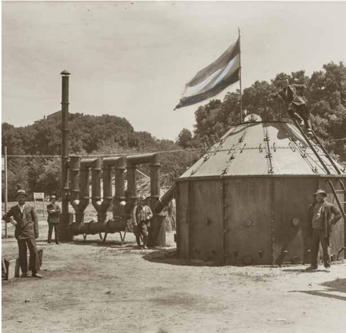
(Fig.37) L'utilizzazione dei residui legnosi nella produzione di carbone in forni metallici (s.l., 1932)
