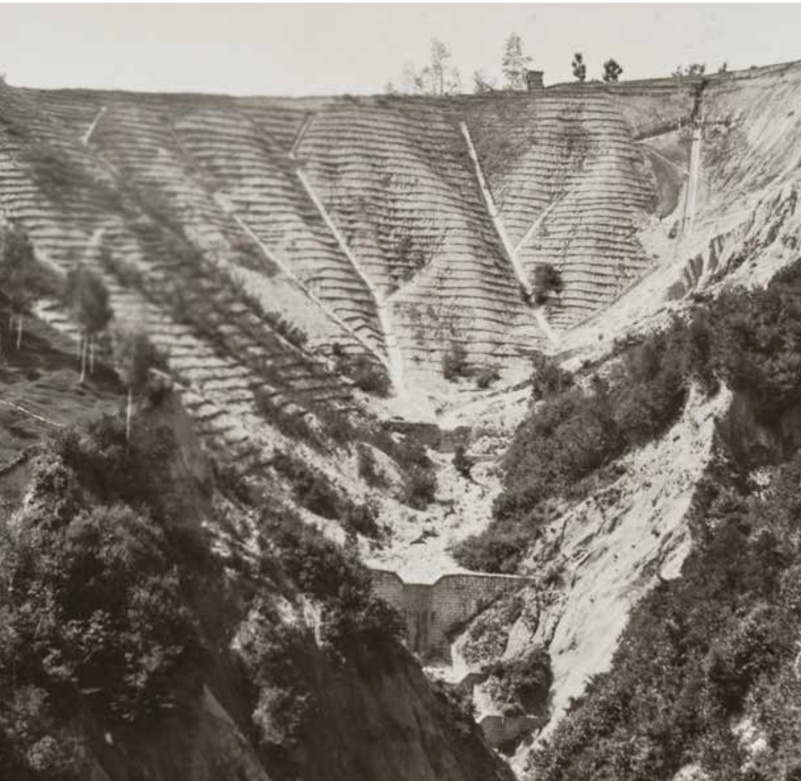
(Fig.8) Grande frana in corso di sistemazione e consolidamento (s.l., 1960)
