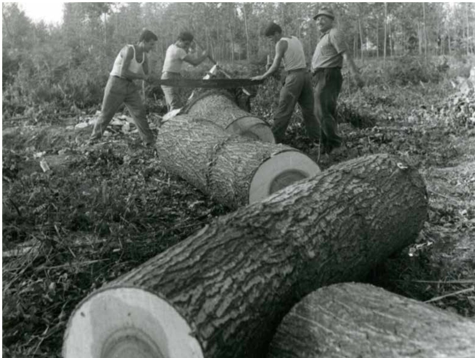
Sezionatura in toppe della parte basale di un bellissimo tronco di pioppo idoneo per la sfogliatura. La colorazione scura del massello non danneggia eccessivamente la fabbricazione dei compensati (s.l., 1960)
