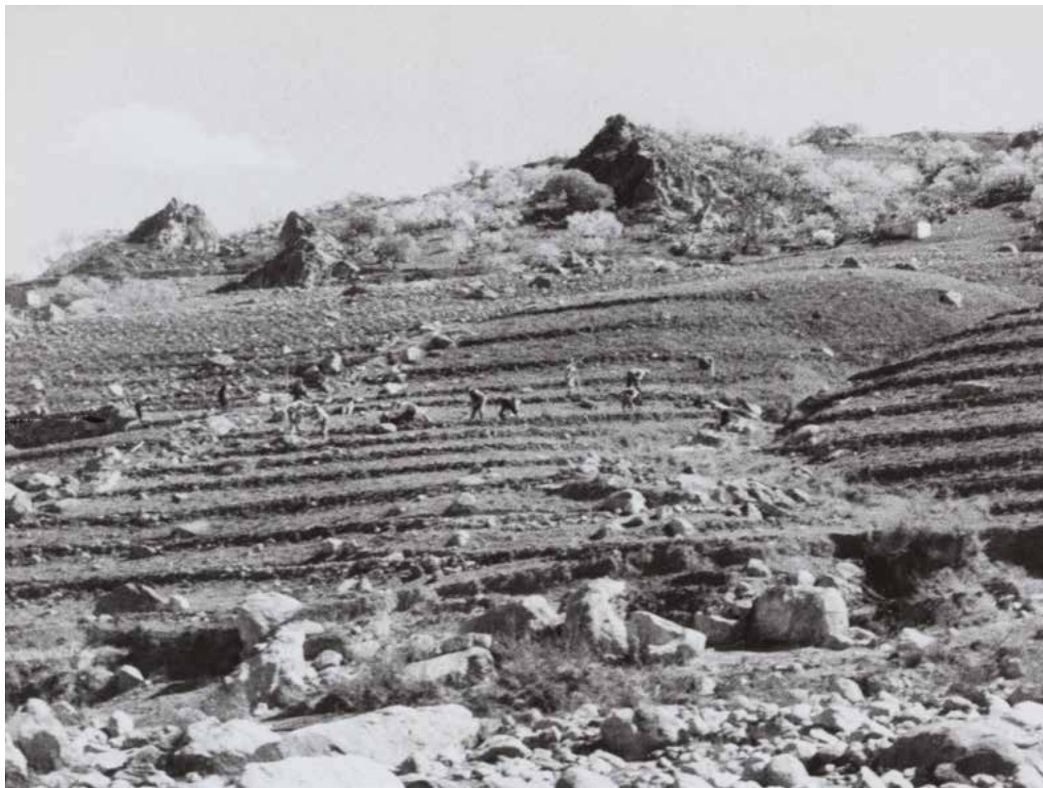
Operai in attività di sistemazione del versante privo di vegetazione (s.l., s.d.)
