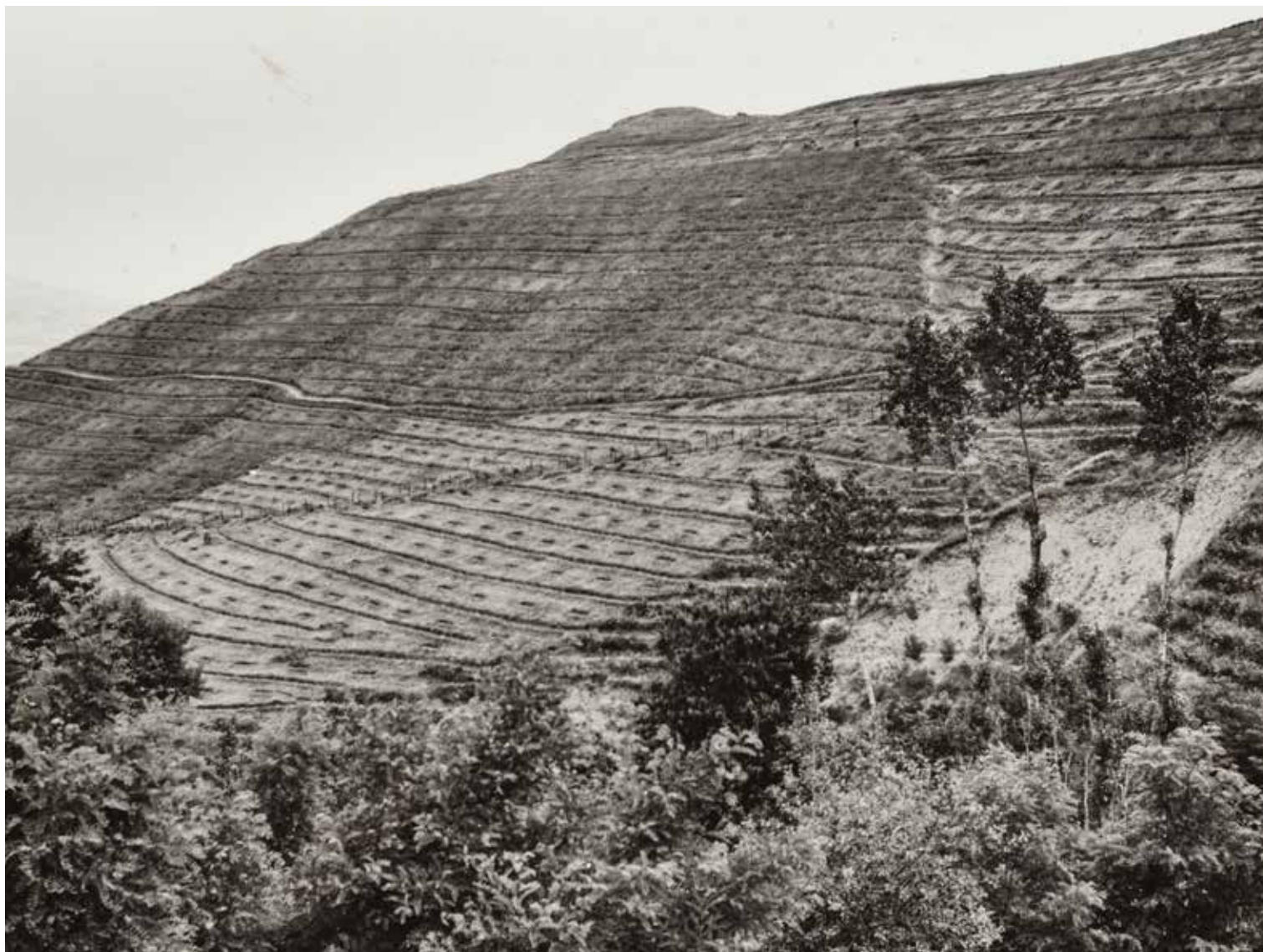
Sistemazione di un pendio mediante apertura di gradoni secondo le curve di livello. Ai gradoni è stata affidata la fondamentale funzione di frazionare le acque di pioggia, mettendole così nelle condizioni di giovare alla piantagione, anziché nuocerle (s.l., s.d.)
