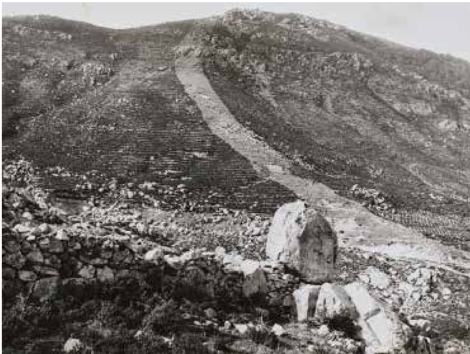
Nei bacini montani del Flumendosa e dei torrenti dell'Ogliastra in Sardegna, il rimboschimento eseguito per semina diretta dei pini mediterranei su terreno sistemato a gradoni ha fornito un ottimo risultato (s.l., s.d.)
