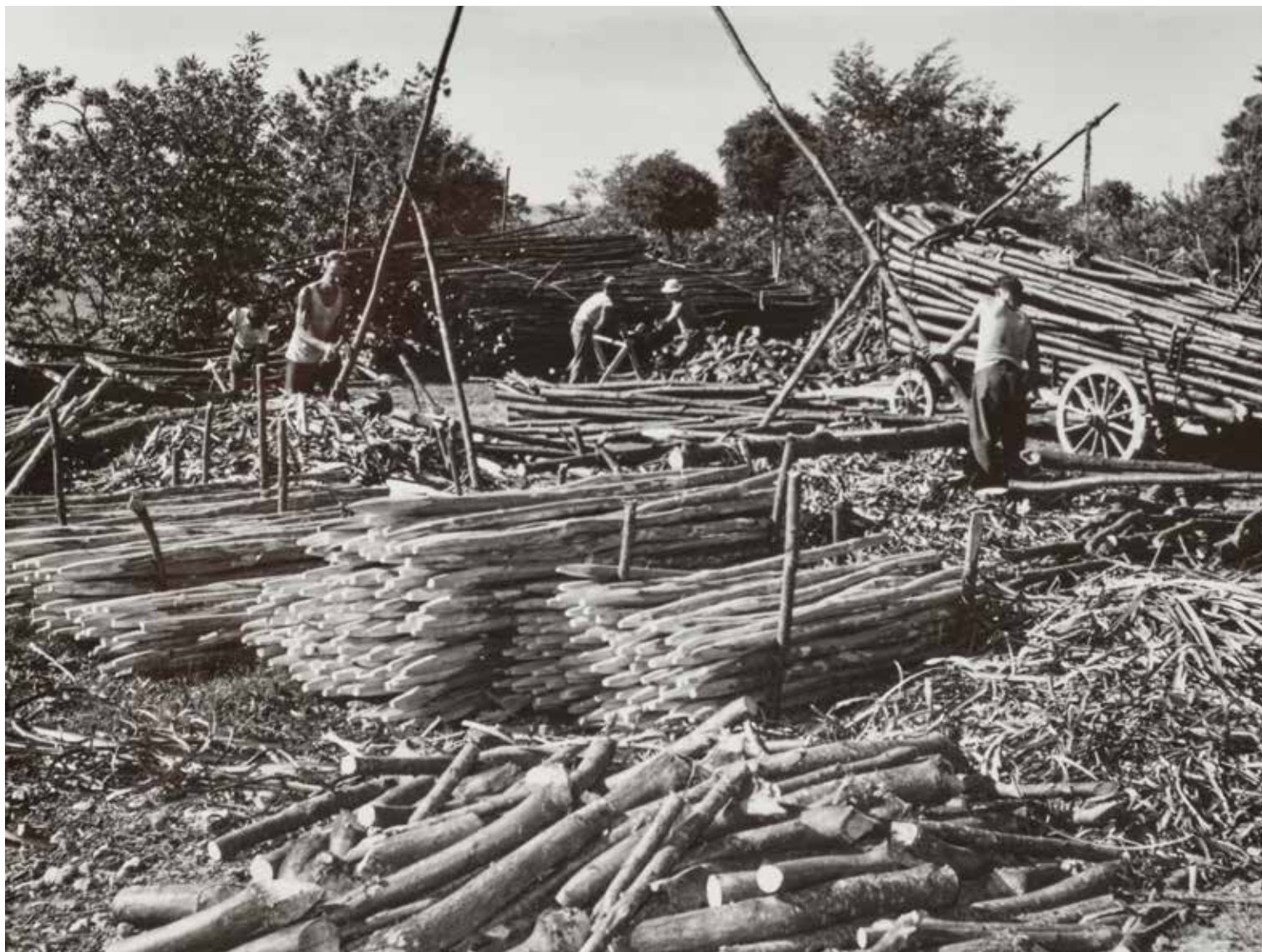
Preparazione dei pali (Palo - Savona, s.d.)
